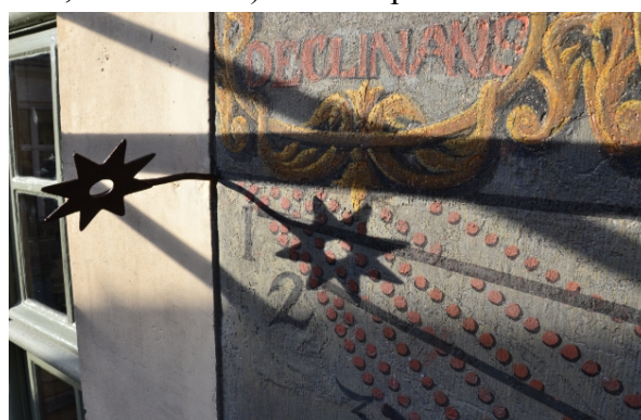
Fig. 24 : Détail de la tache de lumière projetée par l'ocilleton du cadran d'heures planétaires du panneau 1 le 20 avril 2016.
