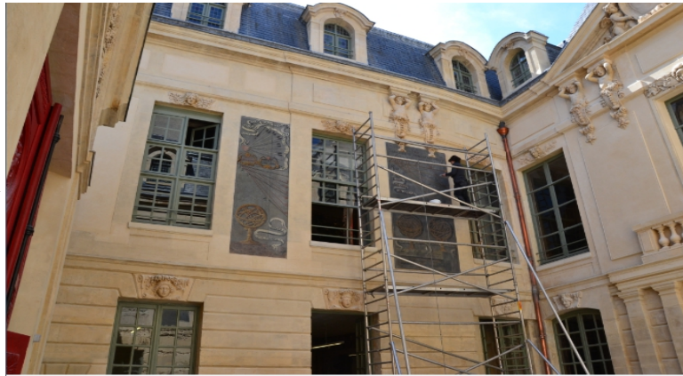
Fig. 21 : Photographie montrant l'artiste- peintre spécialiste en restauration retouchant le cadran solaire du panneau 2.
