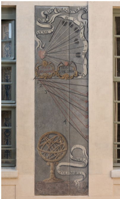
◀ Fig. 22 : Panneau 1 terminé avec son tracé moderne et son style et son gnomon installés.
