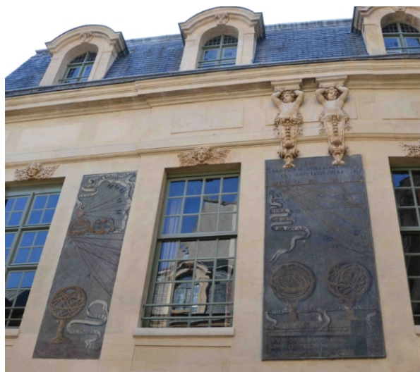
Fig. 1 : Façade Nord-Est de l'Hôtel Amelot de Bisseuil avec ses deux panneaux où sont peints les systèmes cosmologiques et différentes variétés d'heures anciennes indiqués par trois cadrans solaires.
